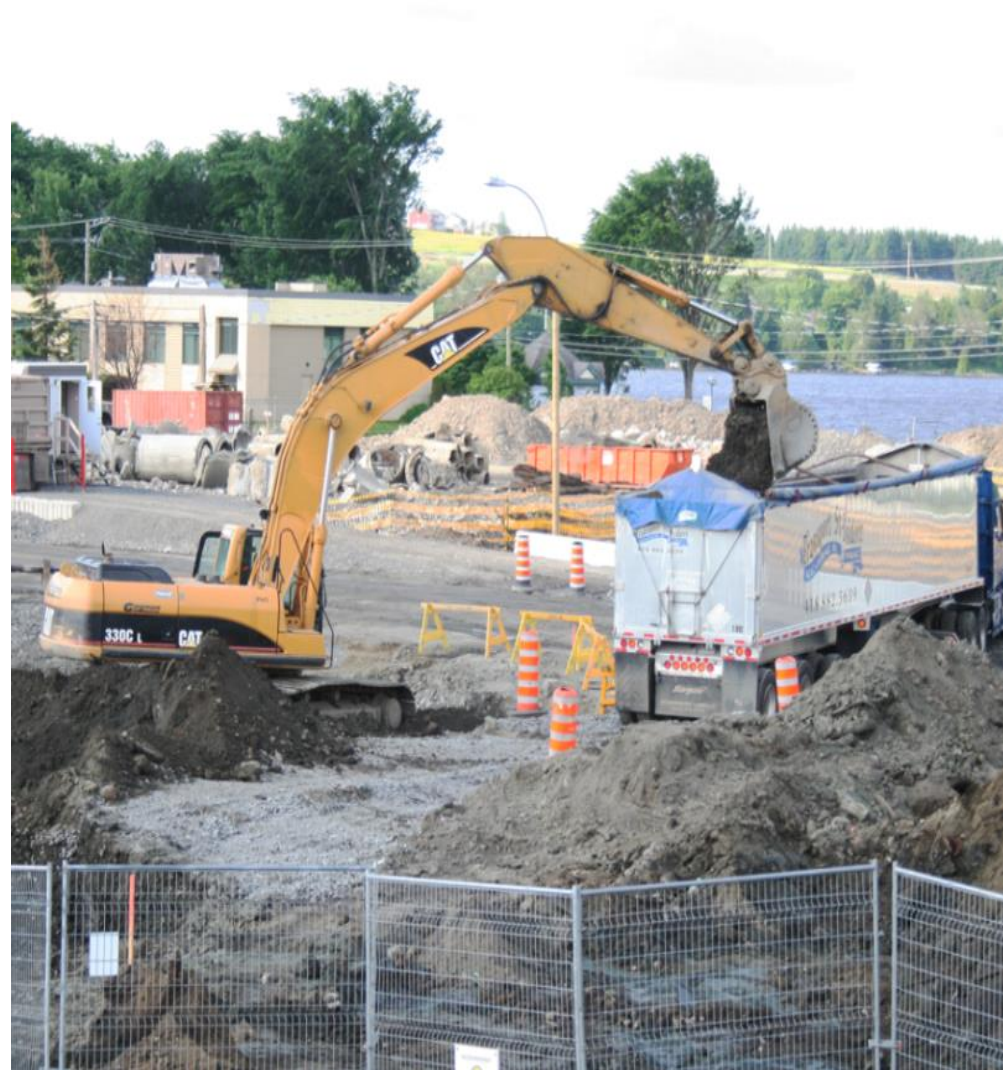
Le sol affecté est chargé dans des camions afin d'être transporté pour traitement/élimination. La Ville de Lac-Mégantic est visible en arrière-plan.
